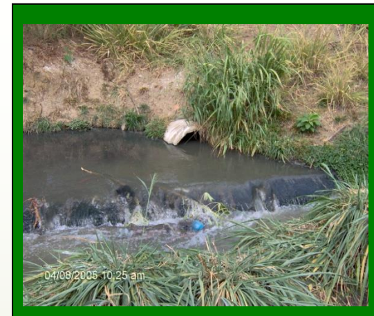
Deterioro del agua
