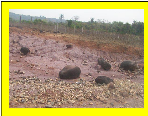
Deterioro del suelo
