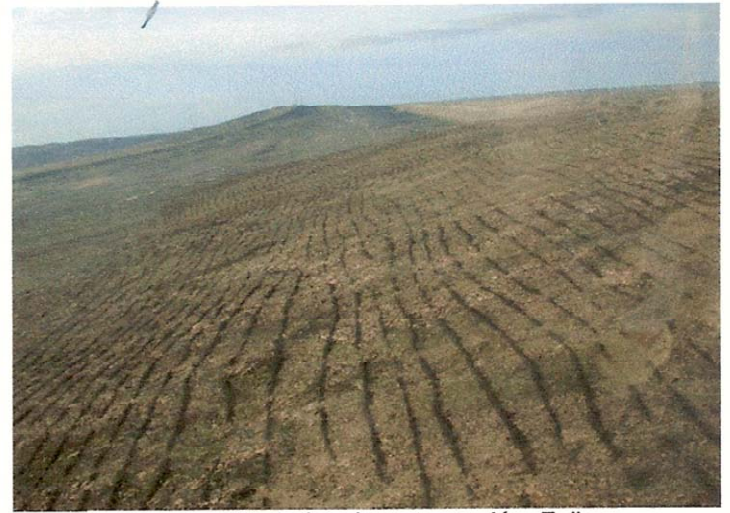
Trabajos de restauración. Fajinas.
